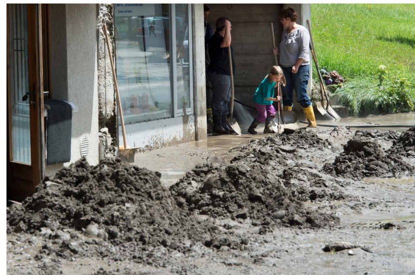
Dommages naturels : travaux de déblaiement après la crue de l'Emme en 2014
