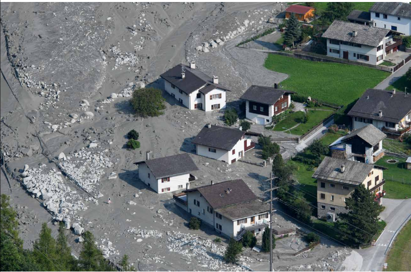
Catastrophes naturelles : un éboulement comme à Bondo en 2017 peut provoquer des dommages considérables.
