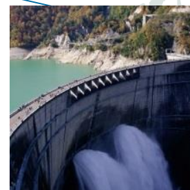
Tanzanie : Sécheresse : risque pour la santé et la production d'énergie
