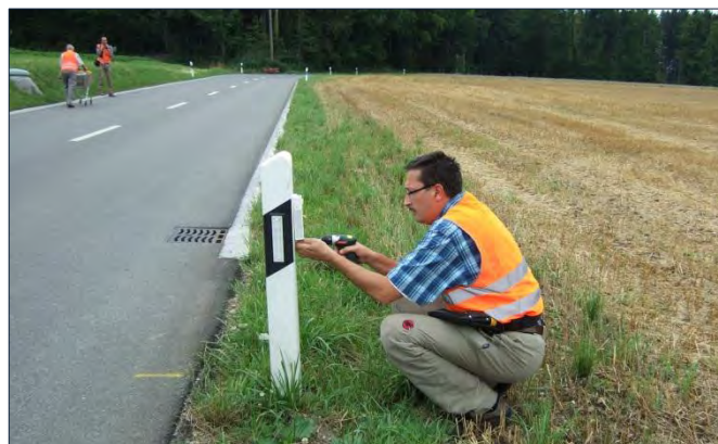
Die akustischen Wildwarngeräte werden an besonders kritischen Streckenabschnitten montiert.
