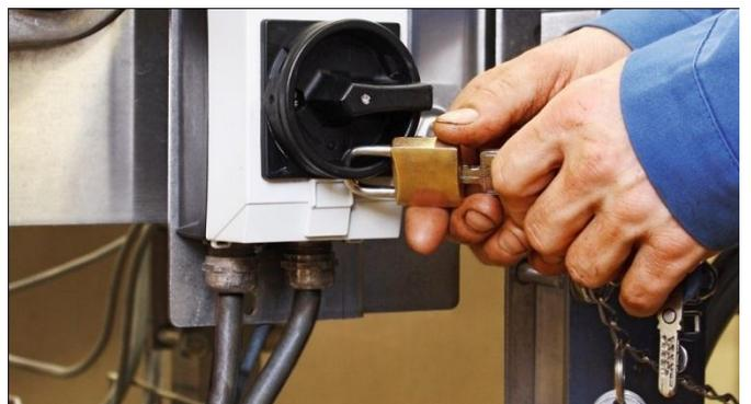
*Vor Instandhaltungsarbeiten müssen Maschinen sicher stillgesetzt und vor unerwartetem Anlauf gesichert werden. (Suva)*
